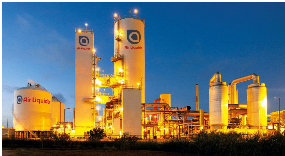
Figura 1: Unidade on-site de separação de ar (Air Liquid).
