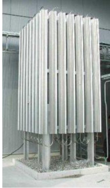
Figura 7: Vaporizador de alta pressão (Cryostar).
